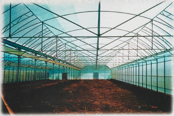
芷村林场双层保温薄膜温室
