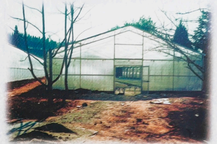
芷村林场PC板温室
