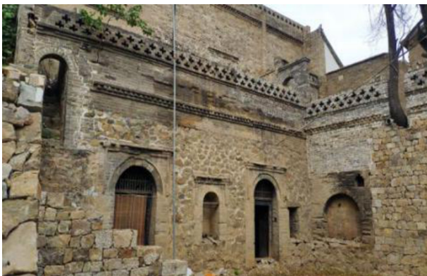
图 5 修缮材料混杂
