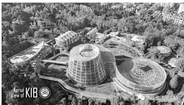
图 2 建设完成后的昆明植物园扶荔宫温室群俯视实景
