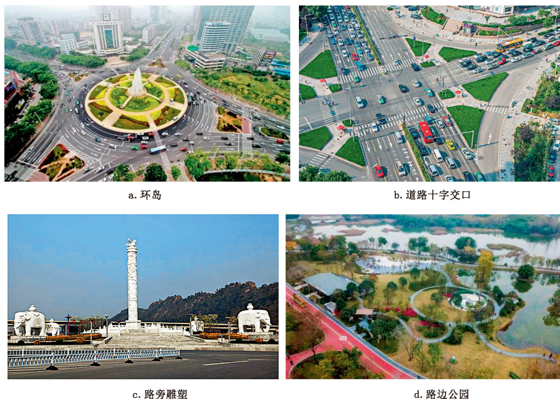
图 1 常见市政道路节点实景
