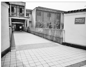
图 10 二号出入口 Fig. 10 Entrance No. 2
