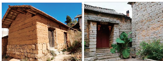
图 2 土木结构的民居风貌和石木结构的民居风貌
